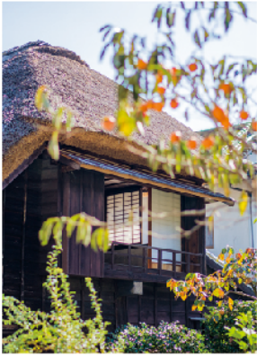
茅葺屋根に情緒を感じる施設
